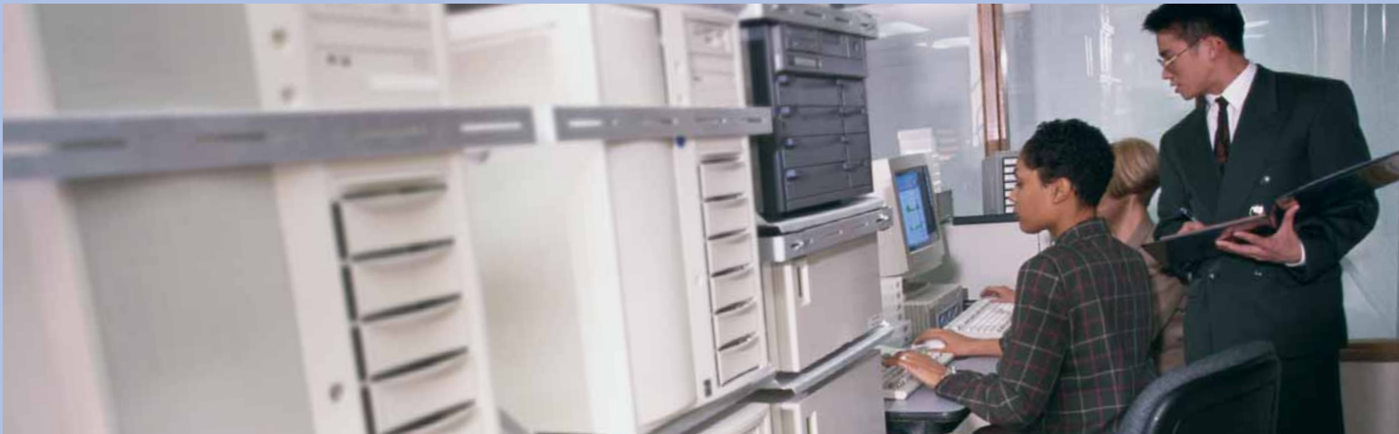
Centre de données (data center) : Application de sécurité
